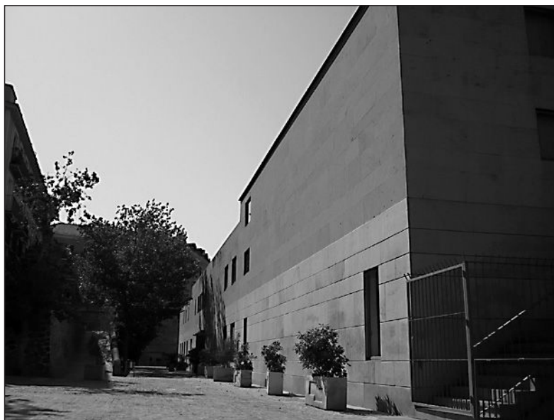
Fig. 4: Fachada sur y plaza de acceso al museo.
