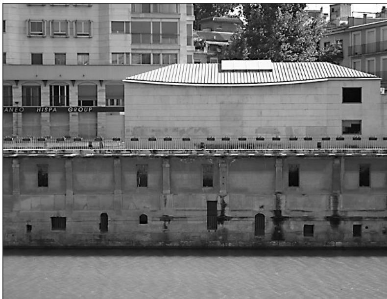
Fig. 2: Vista parcial de la fachada norte: biblioteca.
