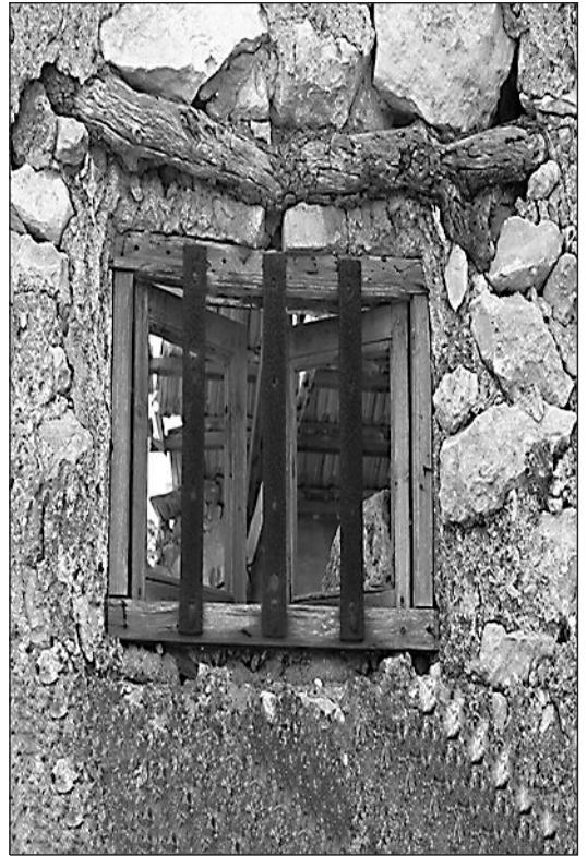
Fig. 3: Vano abierto en el muro. 2006. Los Molinos.
