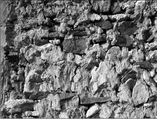
Fig 1. Detalle del muro con la piedra careada. 2006. Perú. foto: Raquel Arango Zapata)
