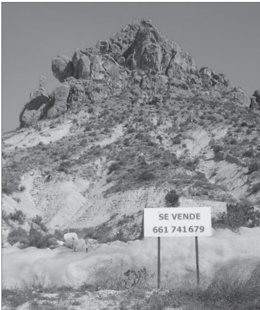
FIGURA 6 Recubrimiento con cemento proyectado del pie del talud
