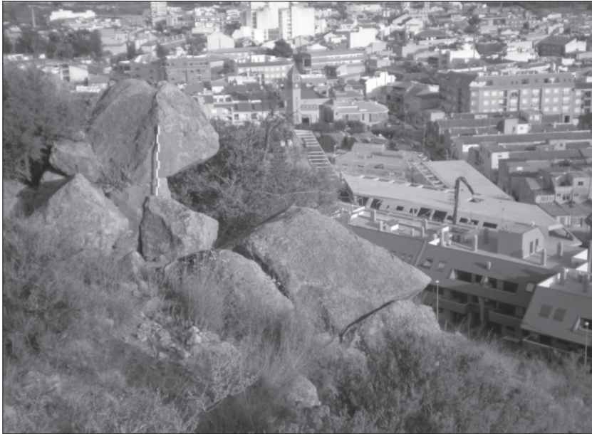
FIGURA 3 Bloques sobre el talud sur (a)
