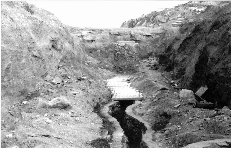
Foro 6. Detalle de los pozos verticales o lumbreras del Caño y Contracaño en Puerto Lumbreras.
