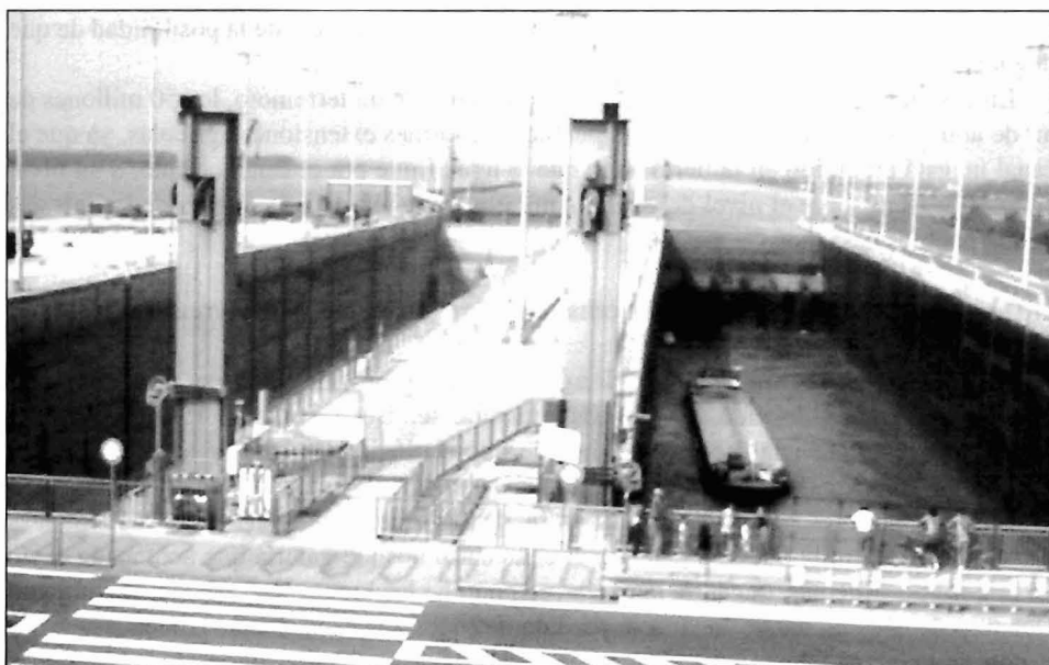
Foto 10. Esclusas para la navegación en la presa de Gabčíkovo; los barcos ascienden o descienden por el canal, salvando los 20 metros de desnivel de la presa.
