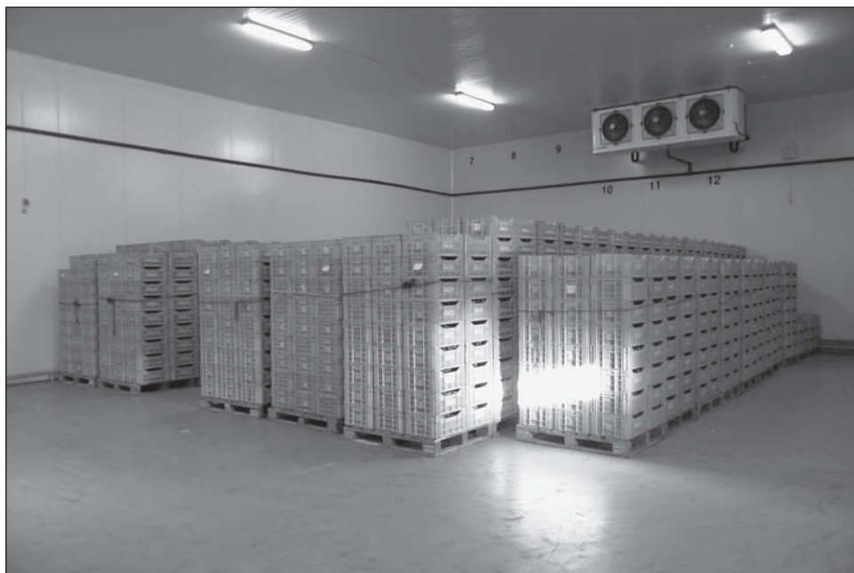
Foro 13. La revolución en los sistemas de conservación en frío. Cámara de preenfriado en una central hortofrutícola.
