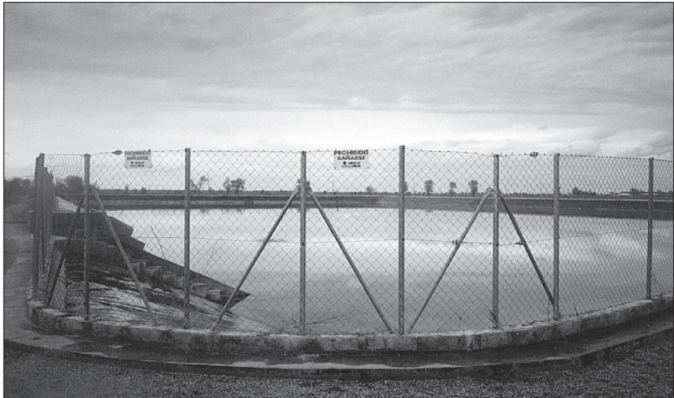
FOTOGRAFÍA N° 4: Embalse construido en tierra e impermeabilizado con E.P.D.M. de una capacidad de 100.000 m 3 [K.C]
