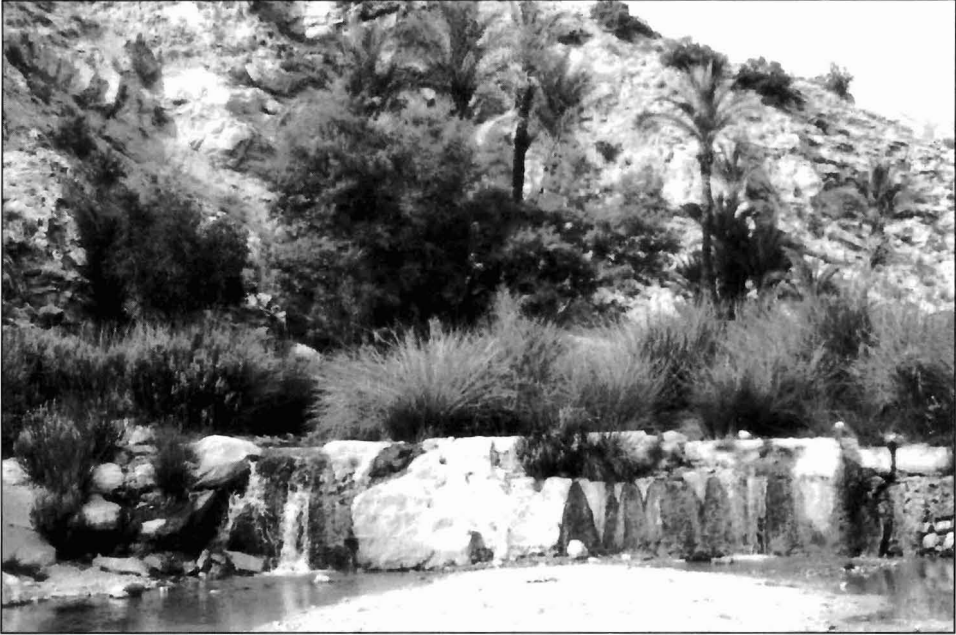
Foto 1. Presa o azud en la cabecera del río Chícamo de donde se derivaba el agua al molino.
