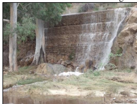
FIGURA 15 Aliviadero de la Boquera General de Tiñosa en la margen izquierda del Garruchal
