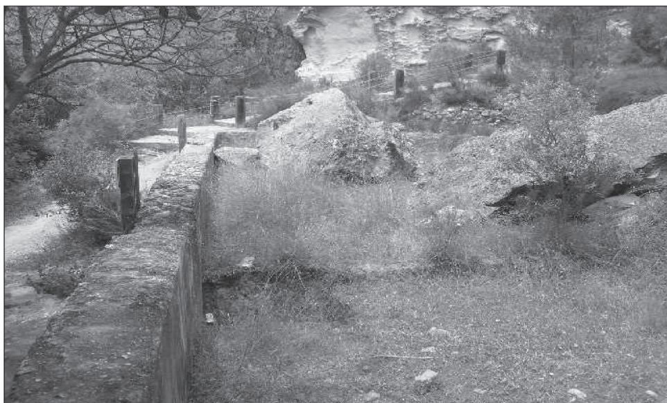
FOTO N° 9 Restos de la balsa que recibía las aguas alumbradas por la galería del Estrecho de la Arboleja (Cercanías Rambla de Lebor).
