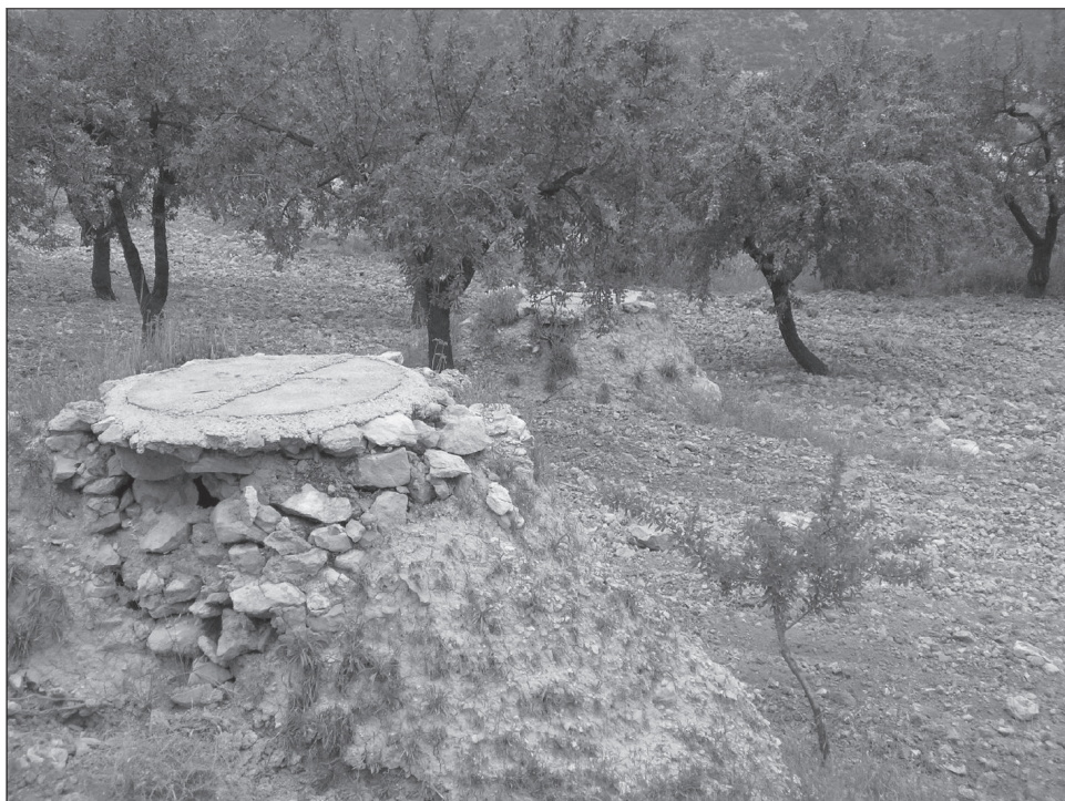
FOTO N° 14 Lumbreras de la galería de Zarzadilla de Totana. (Lorca).
