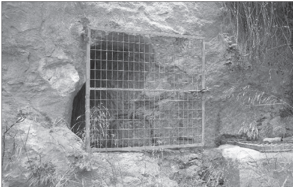
FOTO N° 8 Salida de la galería del Estrecho de la Arboleja.
