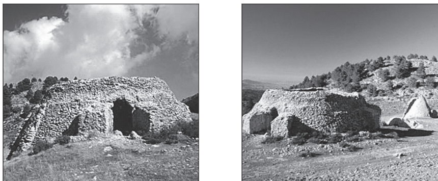
FIGURA 3 Pozos de la Nieve antes de su reconstrucción.
