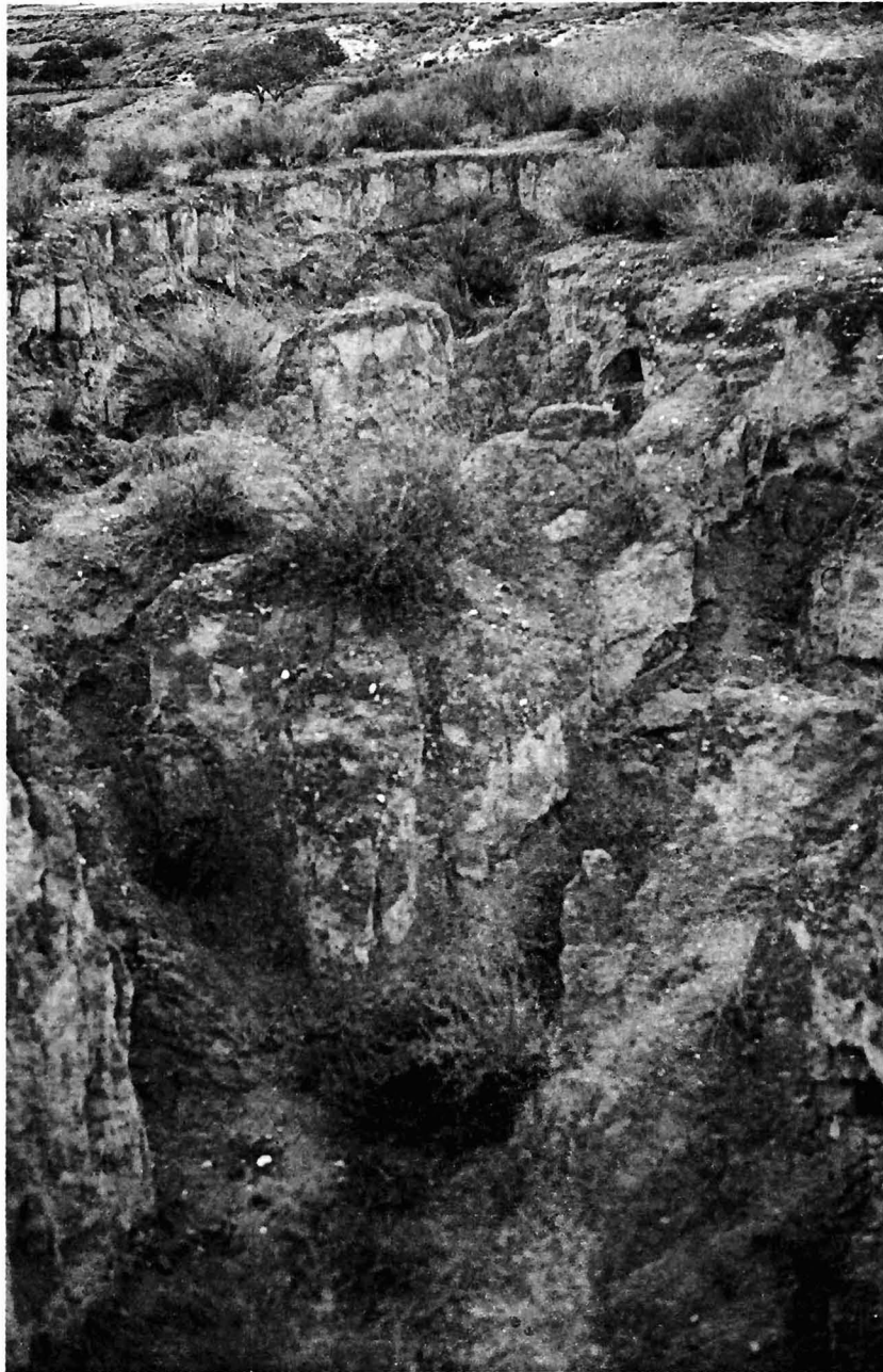
Fig. 4.—Aspecto de la cárcava originada por hundimiento de la bóveda y evacuación de sedimentos, en los materiales neógeno-cuaternarios del Campo de Mazarrón. Terreno cultivado hasta el año 1972 y posteriormente abandonado (23.5.85).
