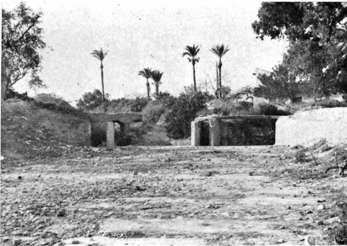
Figura 2.—División de la boquera principal, que ha tomado las aguas en la presa del Puerto del Garruchal.
