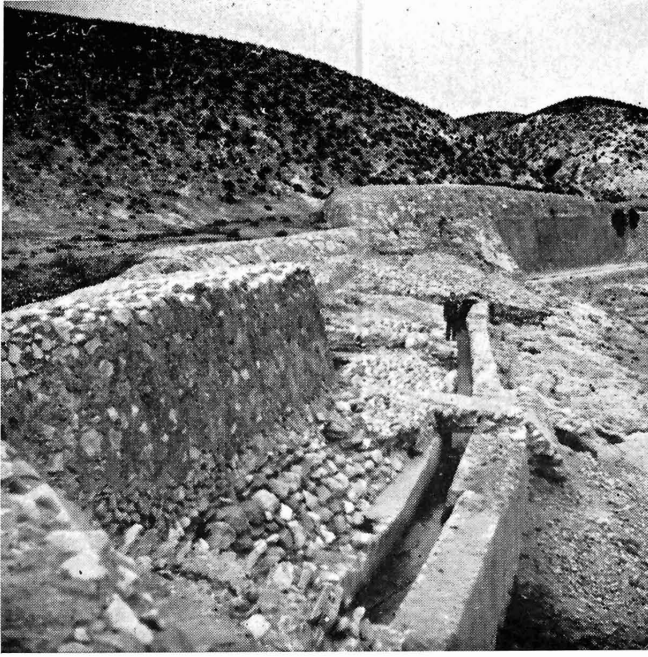
Figura 1.—Muro de separación entre los cauces de la rambla y la boquera, ya que esta última va paralela a la primera en más de un kilómetro. Rambla del Moro (Jumilla). El canal que se ve en primer plano es para aprovechar las aguas subálveas que afloran en la parte baja de la presa.
