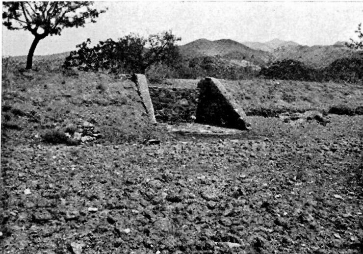
Figura 2.—Detalle de un sangrador, en las proximidades de la Casa del Portazgo (Aguilas)
