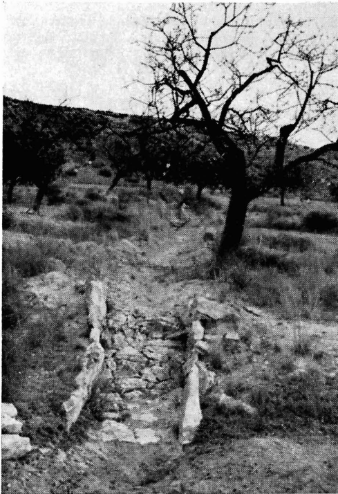
Figura 2.—Boquera con sangrador en su cauce, cruzando los bancales que riega. Gea y Truyols (Murcia).
