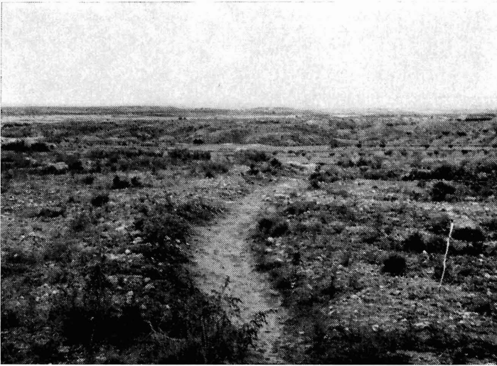
Figura 1.—Boquera hecha sobre una cuesta. Al fondo se ve el valle subsecuente que va a regar.
