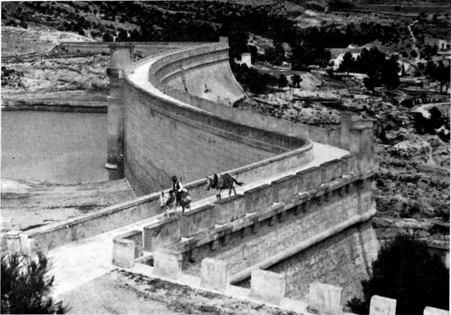
FIG. 1 Presa del embalse de Puentes.
