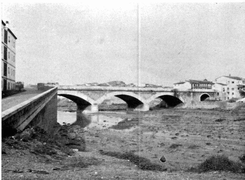
Fig. 1.—Puente sobre el Guadalentín que une el "barrio" a la "ciudad"
