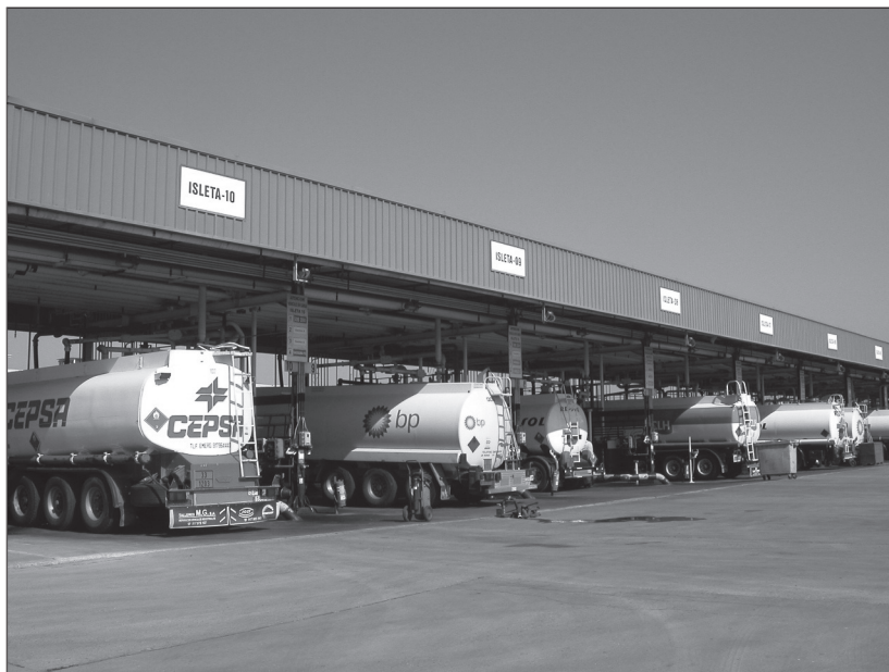
FOTO 4 Cargadero de camiones. Villaverde. Madrid Autor: Compañía Logística de Hidrocarburos
