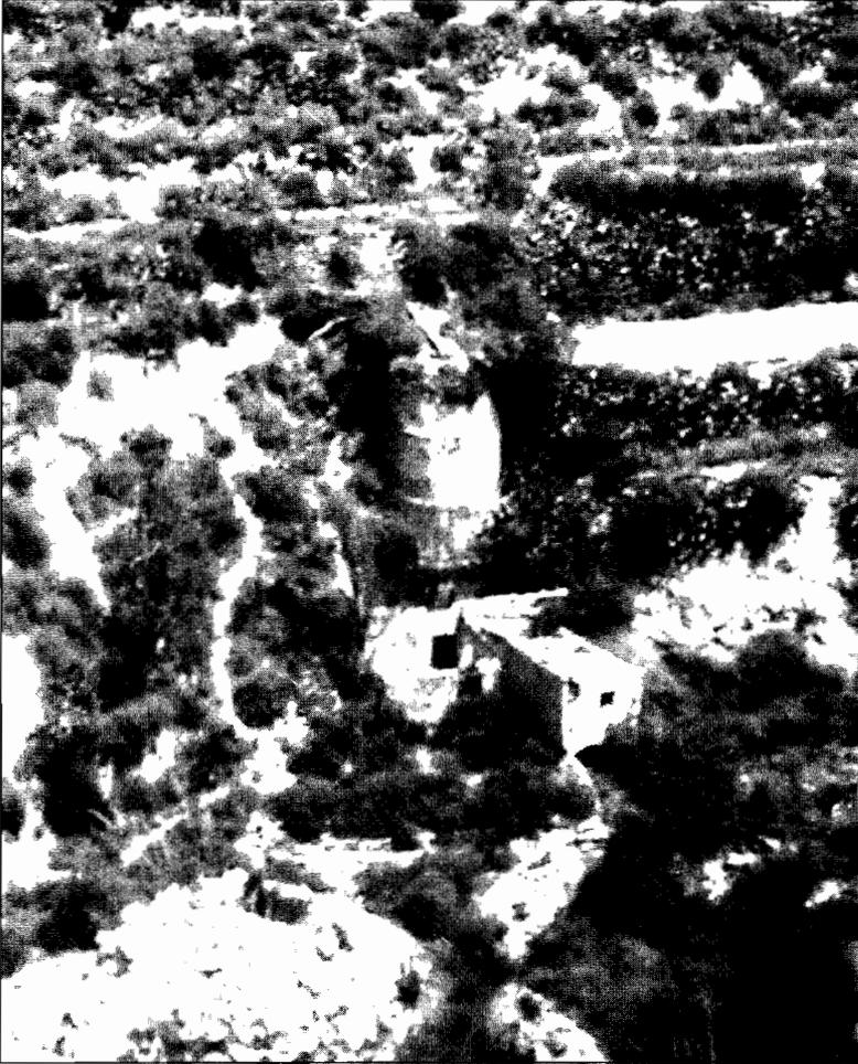
Foto 5. Molino Ramos, donde todavía el agua penetra por la boca de su impresionante cubo, atraviesa el cárcavo y sale al socaz tras salvar un desnivel de unos 12 metros.
