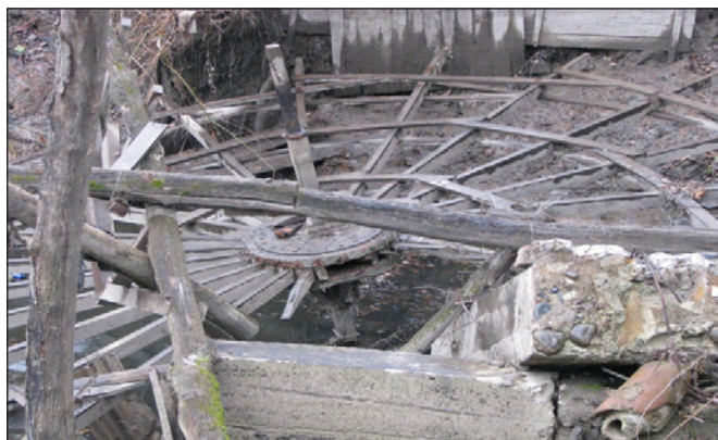
FIGURA 8 Azuda destruida por el terremoto del 2010, actualmente abandonada al borde del Canal Almahue. Pichidegua, Chile.
