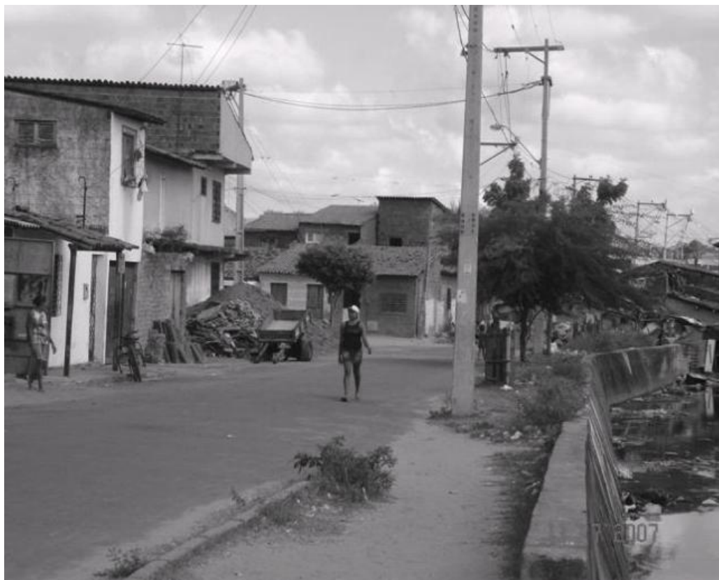
[Figura 2. Pilhas de sujeira e de tijolos ao lado de uma casa abandonada e os canteiros das ruas estão desarrumados e com lixo.]
