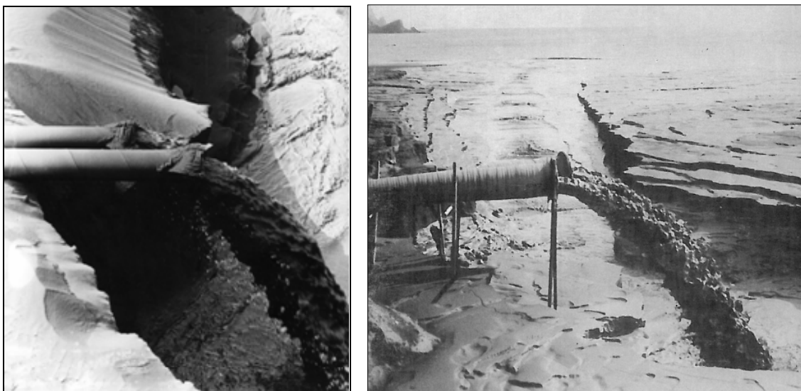
Fig 28 y 29: Diversos momentos de las tuberías de vertido de estériles al Mediterráneo
