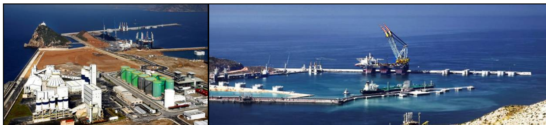
Fig. 59 y 60. Imágenes de la nueva terminal de Escombreras
