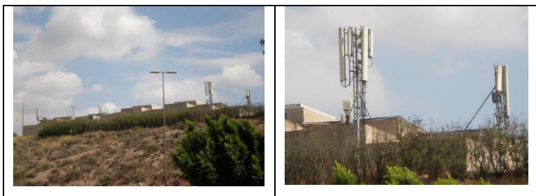
Antenas instaladas en los Depósitos del Agua del Campus de Espinardo.
