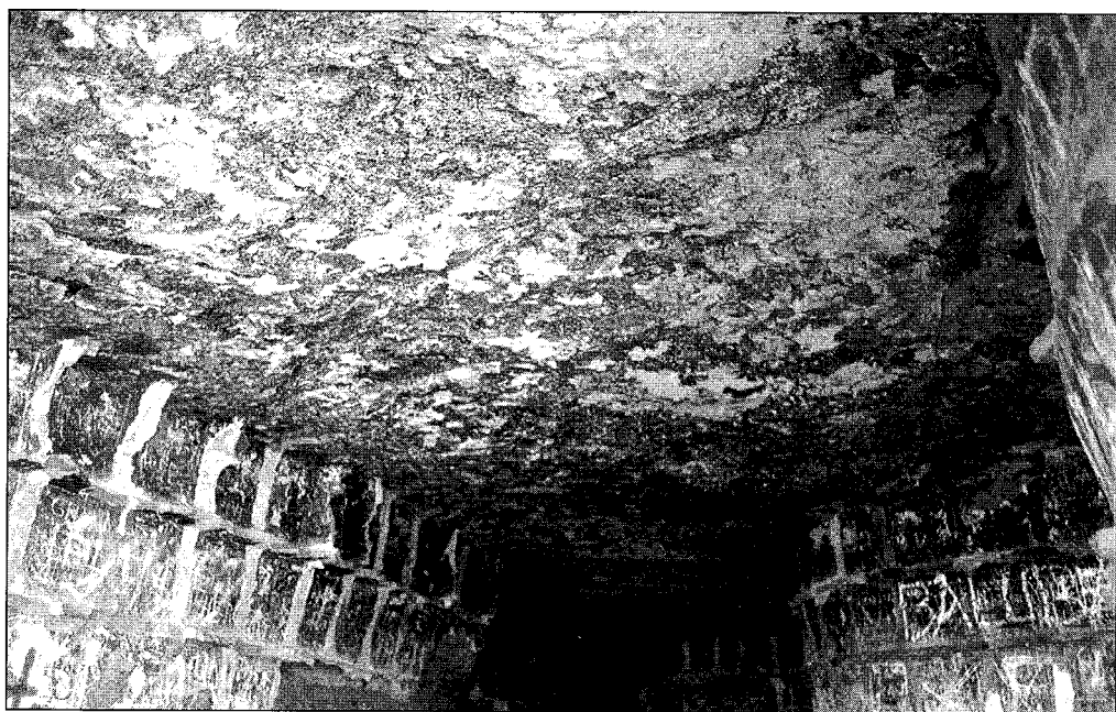
FIGURA 14. Techo de la cueva que se ha excavado pretendiendo hacerlo perfectamente horizontal.
