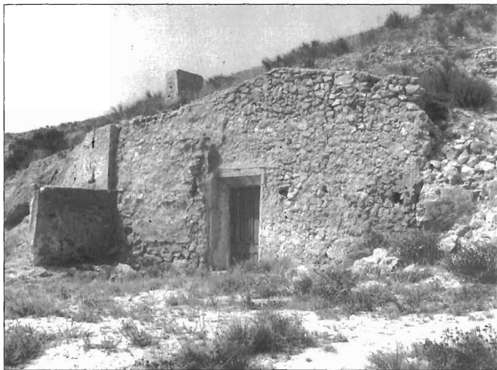
Exterior: detalle del sistema constructivo de la fachada.
