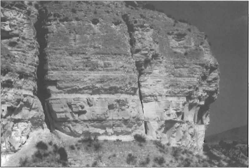
FIGURA 3. Dos importantes fracturas afectan al paquete calizo en donde se halla la cueva. Los procesos de meteorización y su funcionalidad como líneas de drenaje, van ensanchando estos accidentes que, en un futuro muy lejano pueden provocar el derrumbamiento.
