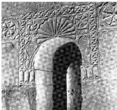
Figura 189. Ventana (iglesia de San Pedro de la Nave-Zamora). (De Barroso Cabrera/Morín de Pablos, 2007: 31, fig. 24).
