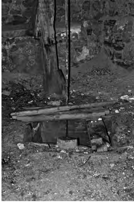
10. Brocal del pozo salinero de abajo.
