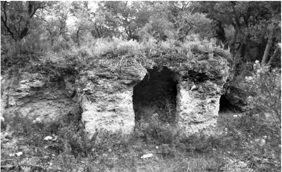
93. Cerrillo con restos de arcos derrumbados.
