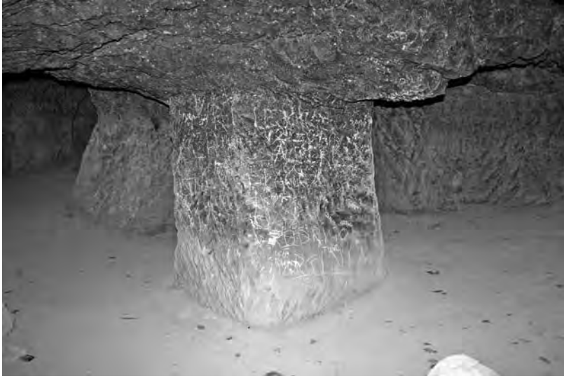
62. Nave mayor N/S. Parte alta, con columna cuadrangular, de gran amplitud.
