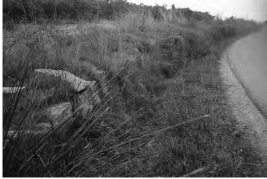
21. Solapamiento de la calzada con la carretera de Haro a San Felices .
