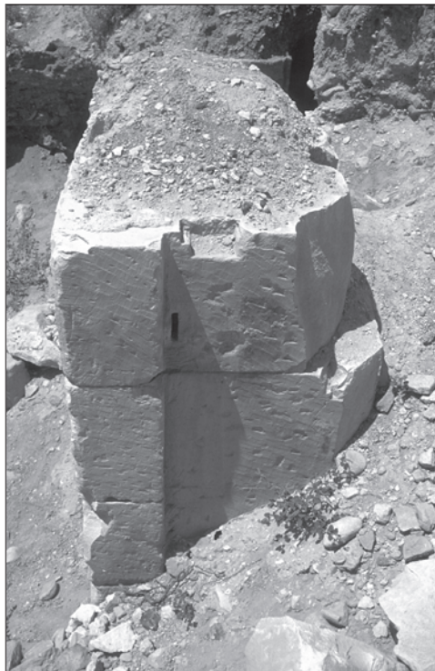
FIGURA 326. Detalle de una de las puertas. El trabajo de sillería es perfecto, así como las marcas de anclajes para las hojas. Ýabal Balūna
