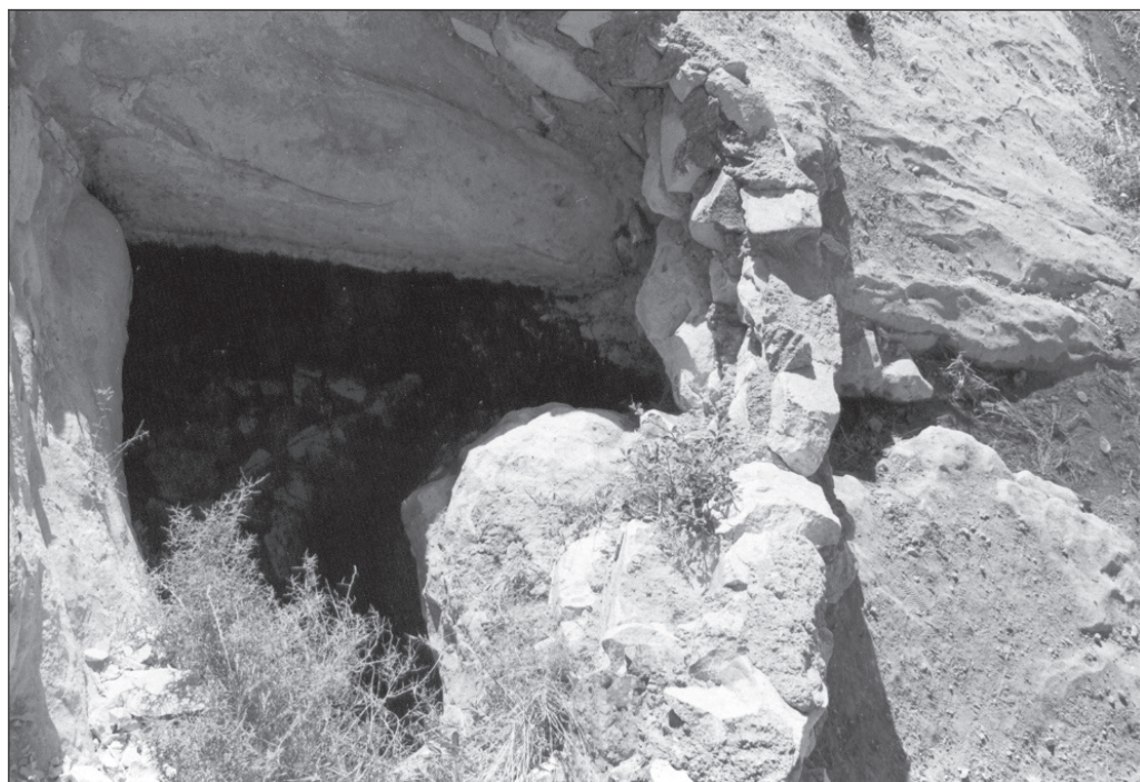
FIGURA 219. HS. Posible caput aquae del acueducto
