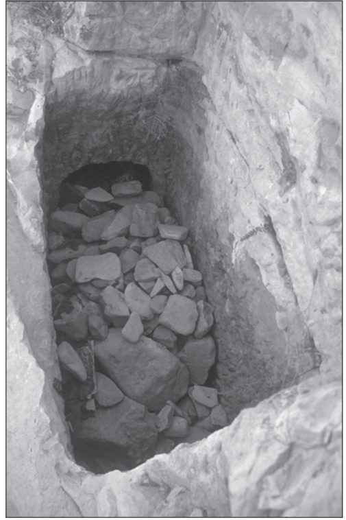
FIGURA 216. HS. Acueducto. Pozo de registro nº 3
