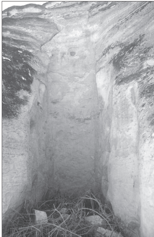
FIGURA 214. HS. Acueducto. Pozo de registro n° 2
