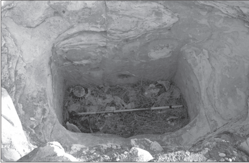
FIGURA 213. HS. Acueducto. Pozo de registro n° 1
