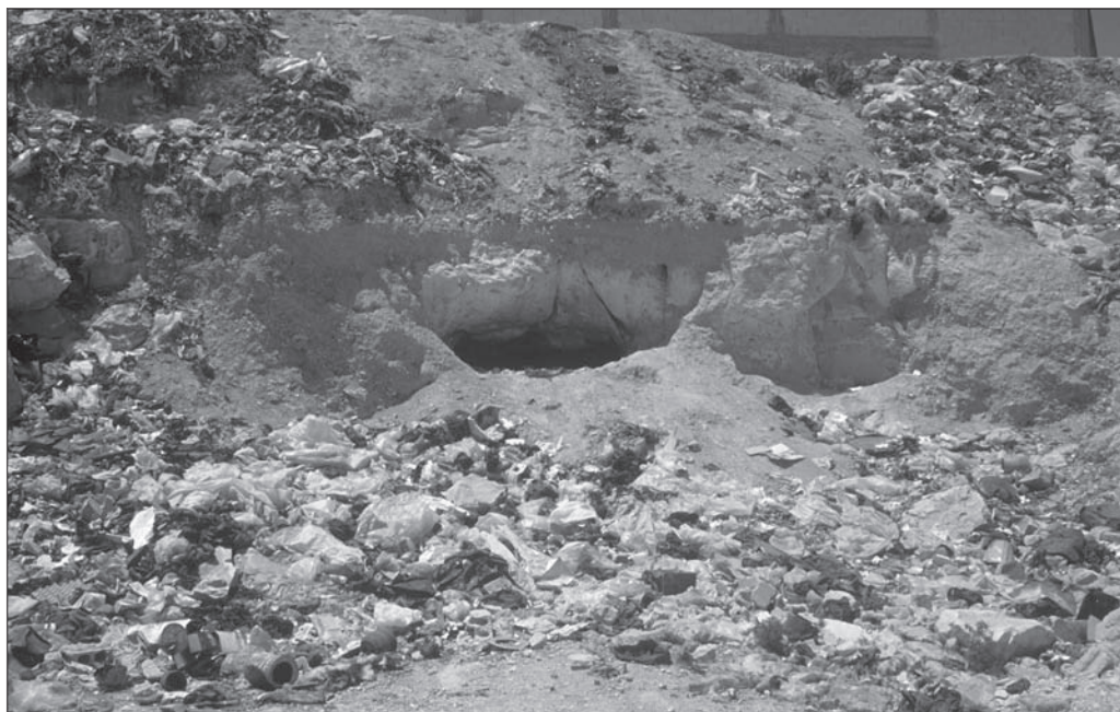
FIGURA 248. Posible aditus del edificio. La basura y escombros prácticamente colmata la entrada
