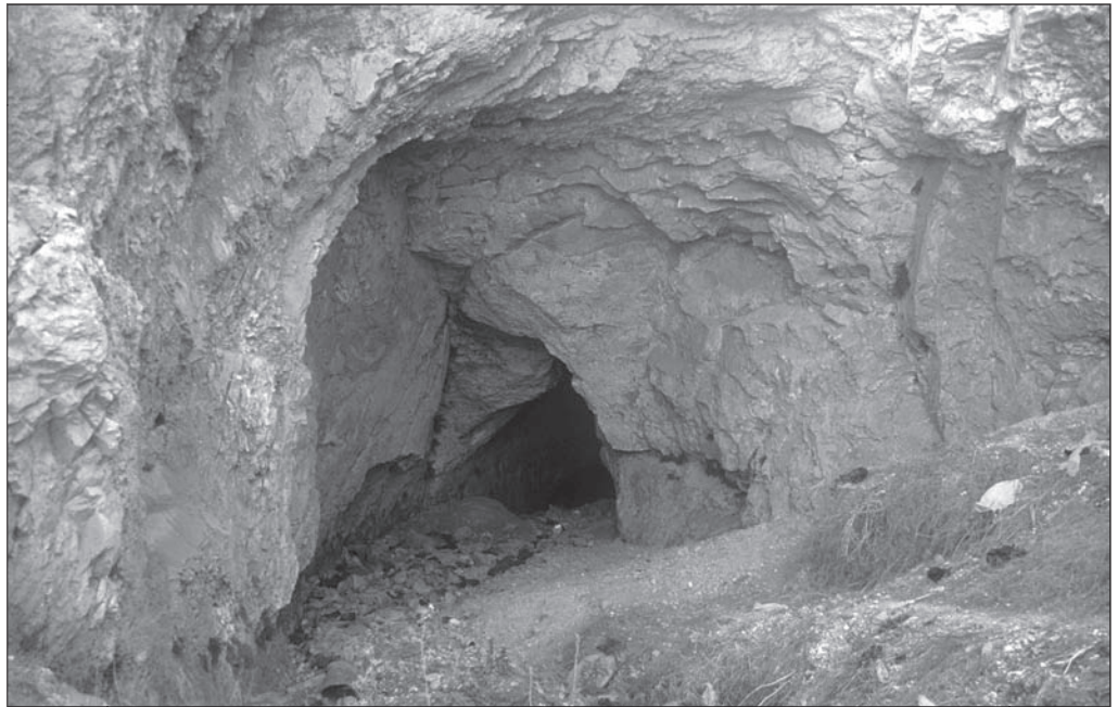
FIGURA 243. Al-Qāra. Boca de acceso al acueducto
