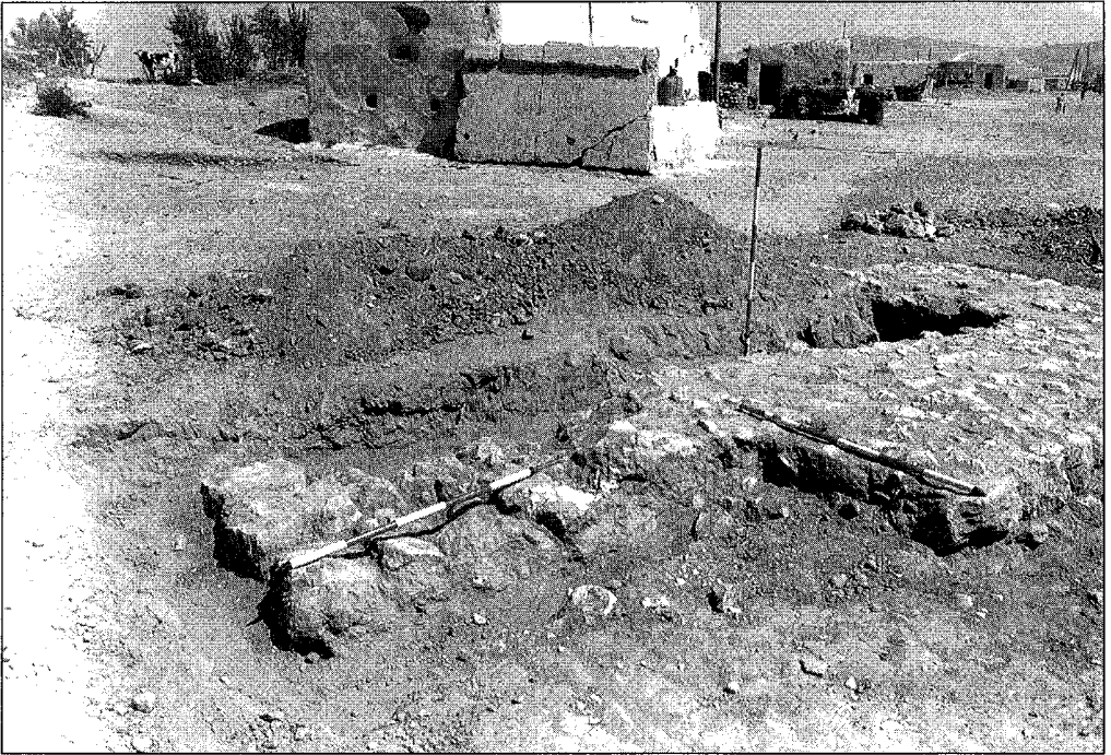
Probables muros de contención en las aguas del río.
