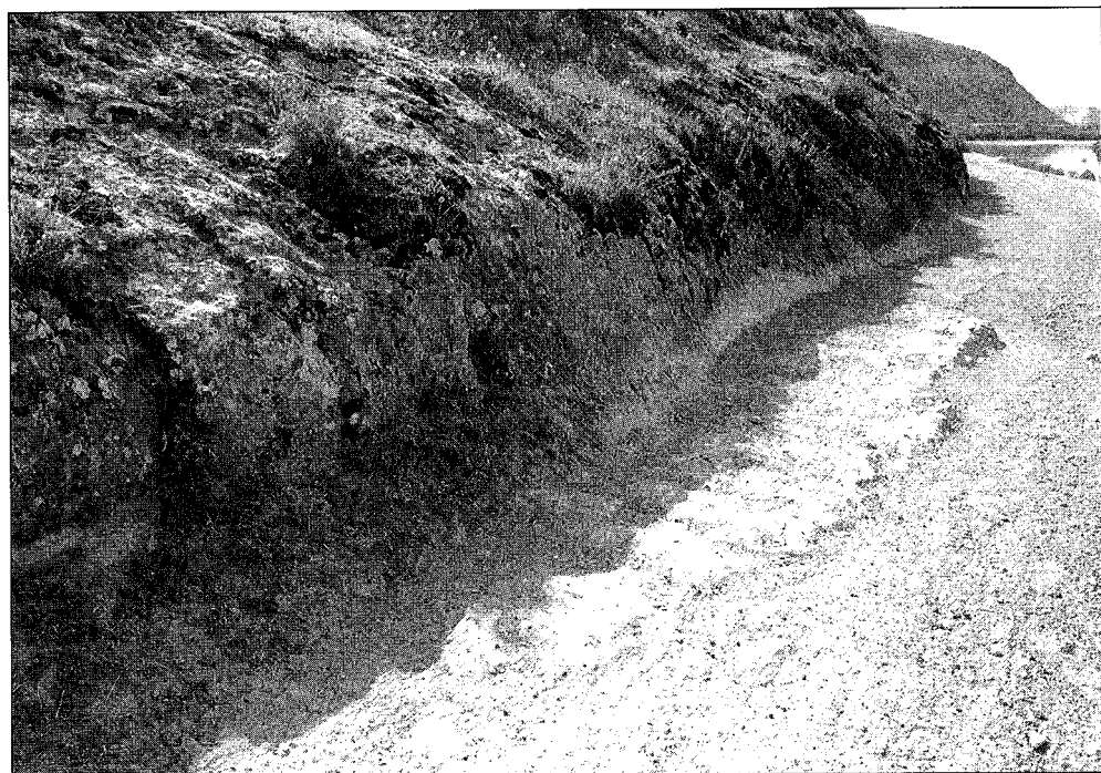
Roca tallada para habilitar el paso de la vía frente a Tell Aḥmar.
