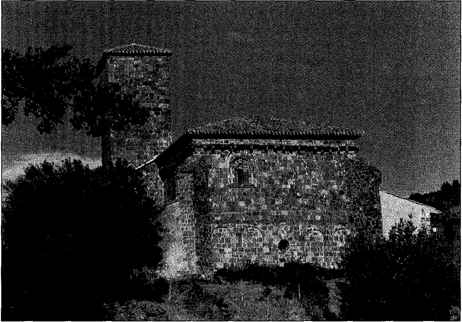
FIGURA 17. Fotografía de la fachada oeste de la Iglesia de Villavelayo.
