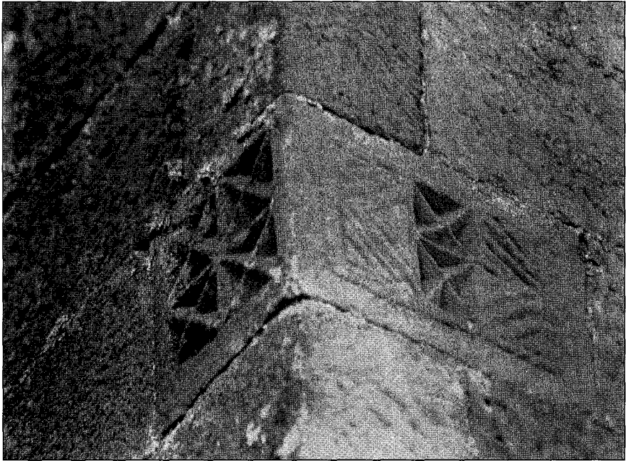
FIGURA 14. Sillar labrado trabajado para ocupar un ángulo de la del edificio en la construcción y decoración, lo que parece probar que tal decoración estaba concebida en franjas.
