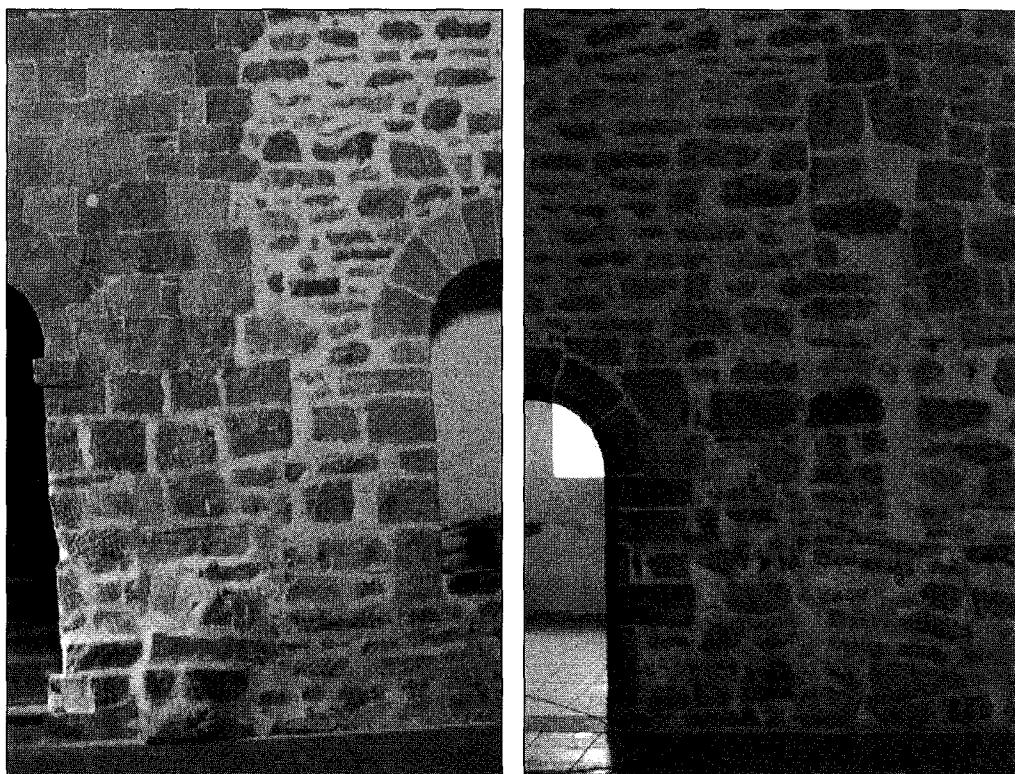
FIGURA 20. Vista del «corte» de las paredes norte y sur de la iglesia, tras de limpiar los muros por el interior: a) muro norte; b) muro sur.
