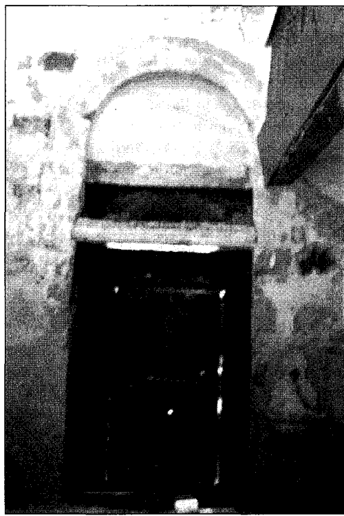
FIGURA 10 bis. Fachada sur. Interior. Arquería de la puerta de la iglesia prerrománica, que más tarde se acomodaría para encajar en ella la puerta románica.
