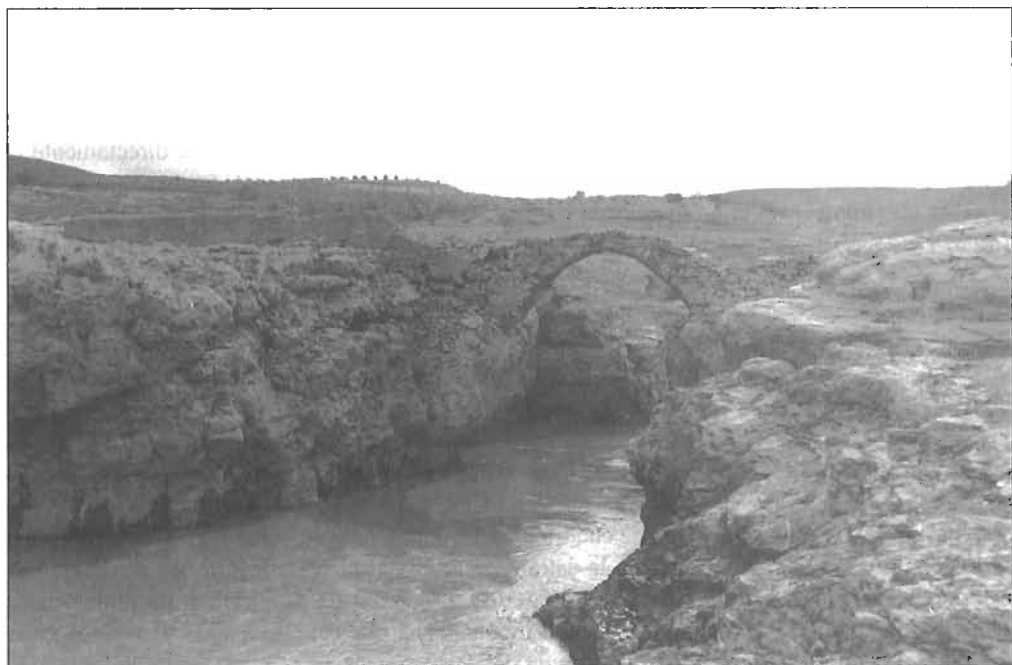
FIGURA 1. Puente de la Alcantarilla de Jover (Hellín y Férez).
