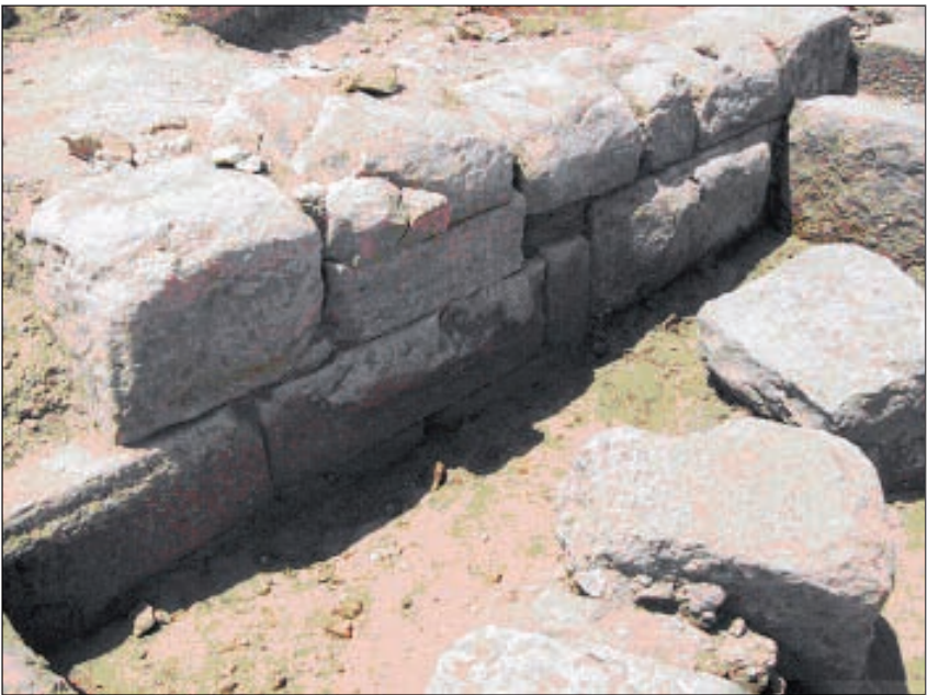
Muro de cierre del recinto
