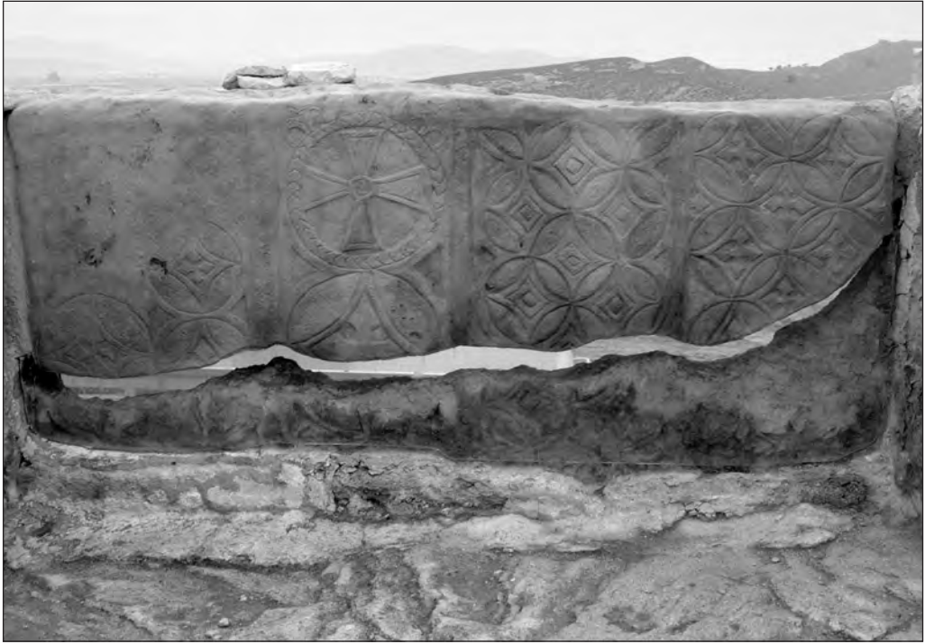
FIGURA 12. Restitución de uno de los cancelos del edificio bautismal. La parte conservada in situ , abajo.
