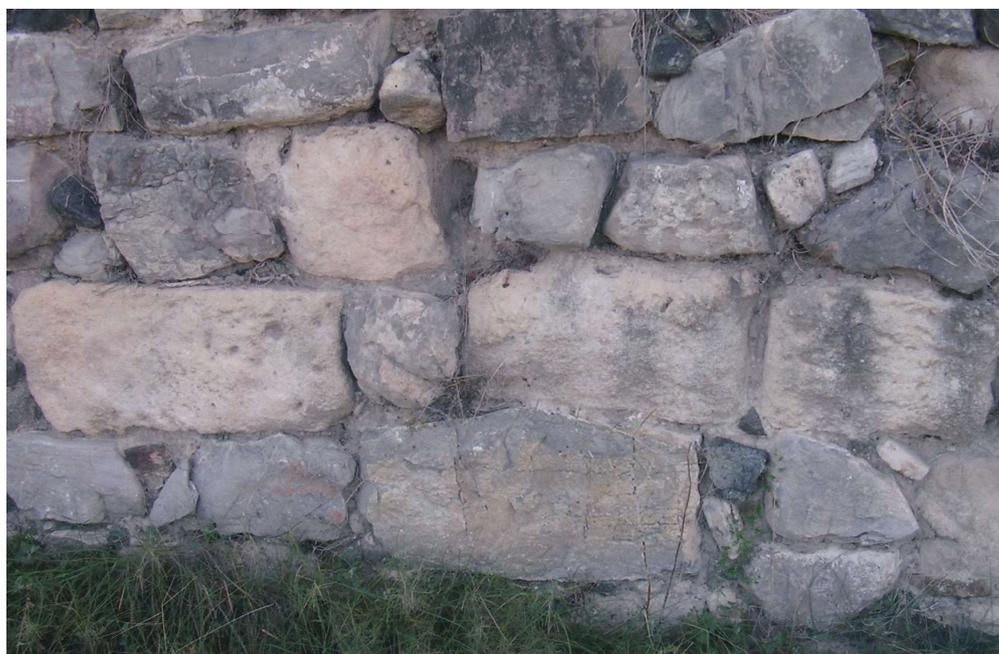
Figura 6. Detalle de los sillares y sillarejos de la muralla del recinto superior por su cara norte.
