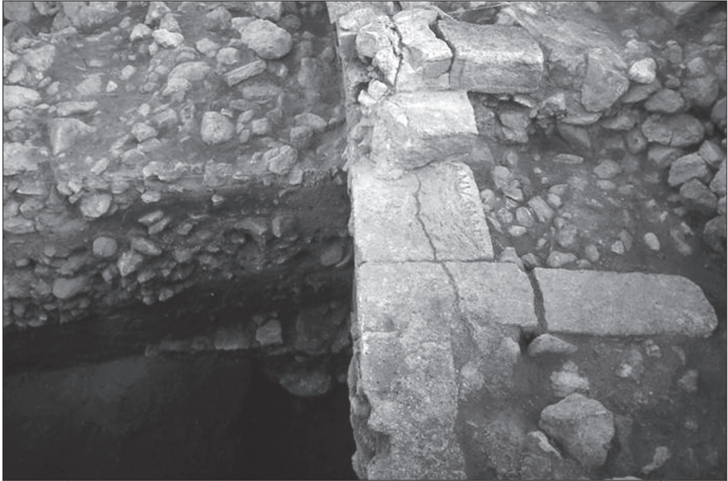
LÁMINA 37: Detalle del sistema de atirantamiento de la muralla del Tolmo de Minateda (Abad, Gutiérrez, Gamo y Cánovas, 2008)
