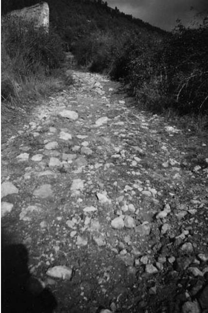
18. Tramo del término La Calzada .
