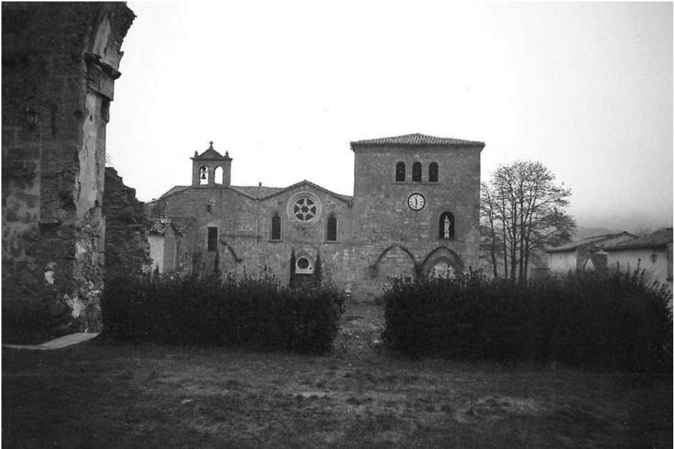
49. Fachada gótica del monasterio de Herrera .
