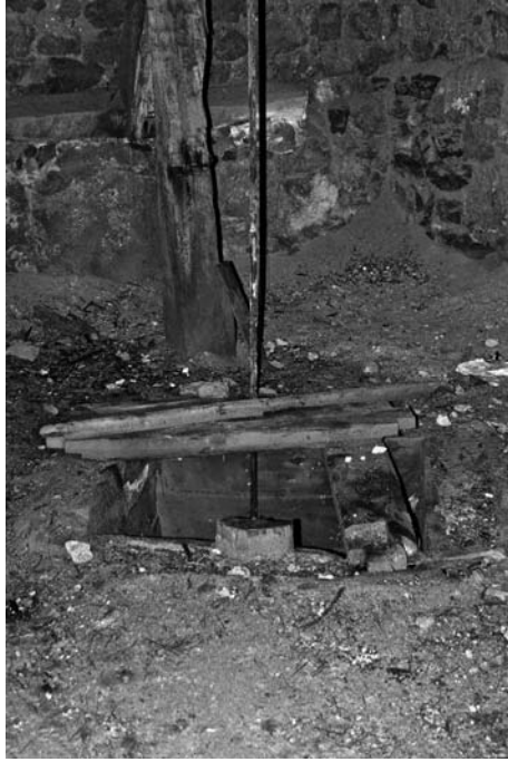
10. Brocal del pozo salinero de abajo.
