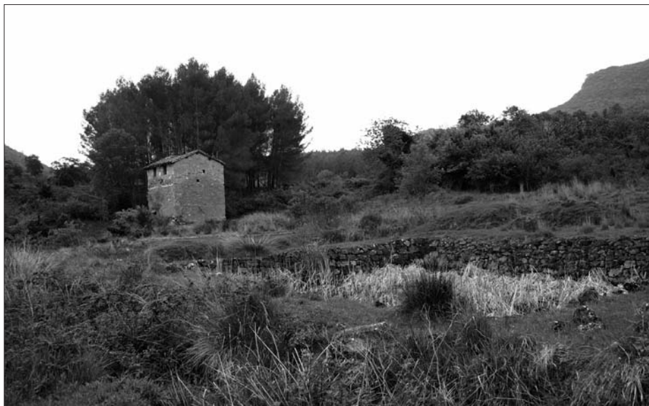
9. Edificio que protege el pozo salinero de abajo.
