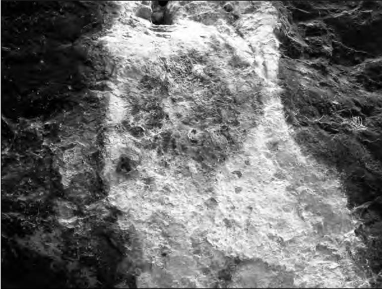
FIGURA 9. *Detalle del área 2, depósitos de elementos contaminantes de combustión y carbonataciones de la superficie.*
