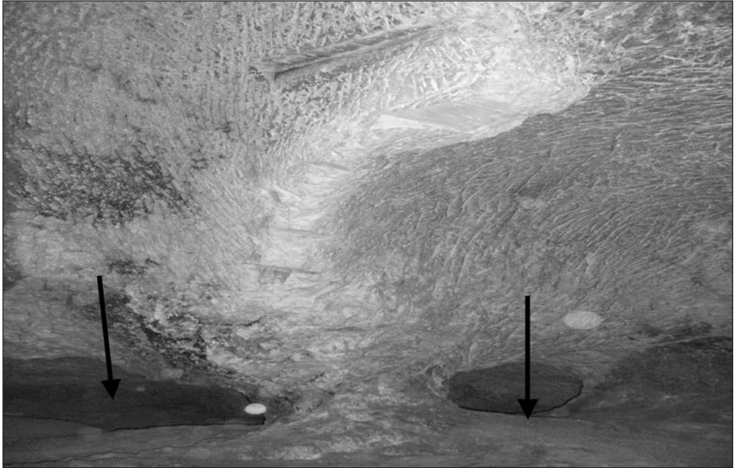
Lámina 4.4.VIII Ventana y orificio de extracción de arena
