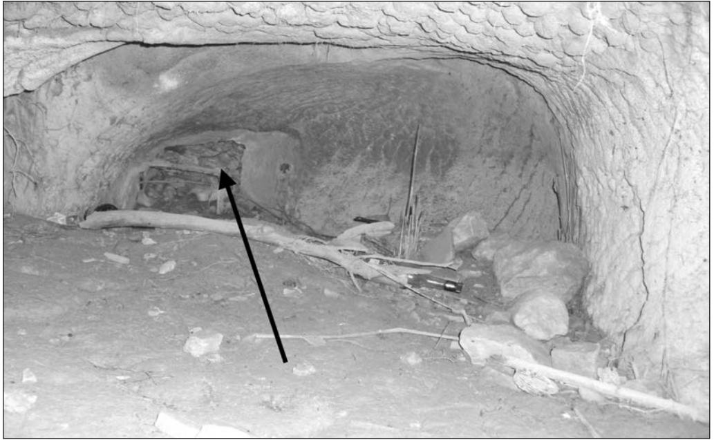
Lámina 3.1.VI Salida del agua utilizada por el molino mediante un minado
