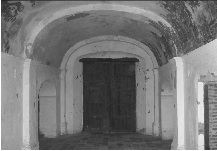
Figura 15. Interior de la iglesia de San Torcuato.
