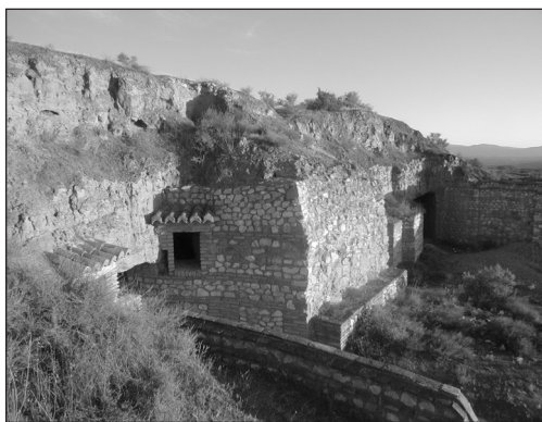
Figura 11. Posible torre, reconstruida recientemente con sillarejo y verdugadas de ladrillo.
