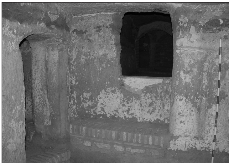
Figura 7. Imagen de las columnas situadas en la estancia número 16.
