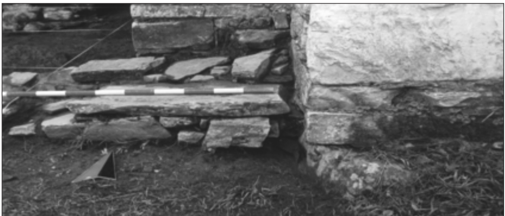
FOTO 21. Encuentro entre la cimentación del pórtico meridional y la Capilla.
