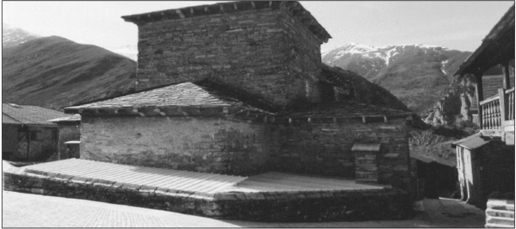
FOTO 1. Cabecera de la iglesia con la protección provisional durante la excavación.
