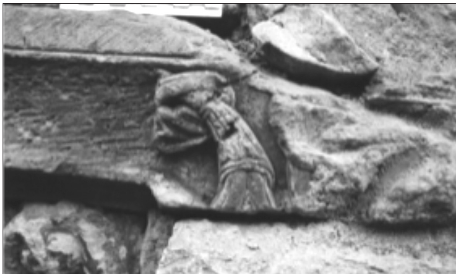
Foto 26. Detalle de la imposta fracturada para su colocación.
