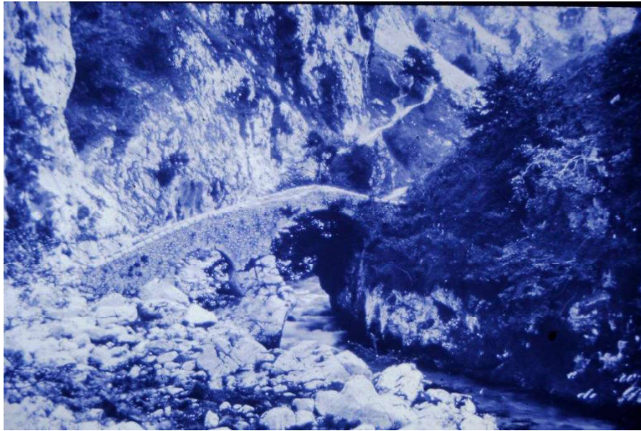
Foto 15: Poncebos (Arenas de Cabrales). El Puente por el que se entraba desde la costa al corazón de los Picos: a Bulnes y al río Duje. Derribado, al parecer, en 1919, cuando la construcción de la electra.
