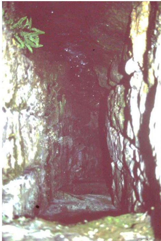
Foto 22 b: Revestimiento del conducto de agua interior con lajas y bloques de piedra. Se añade aún otra fuente inmediata y de aspecto monumental, también con obra de construcción incluida en el terreno, formando con la fuente anterior como un alarde ya de construcción, ya de servicio
