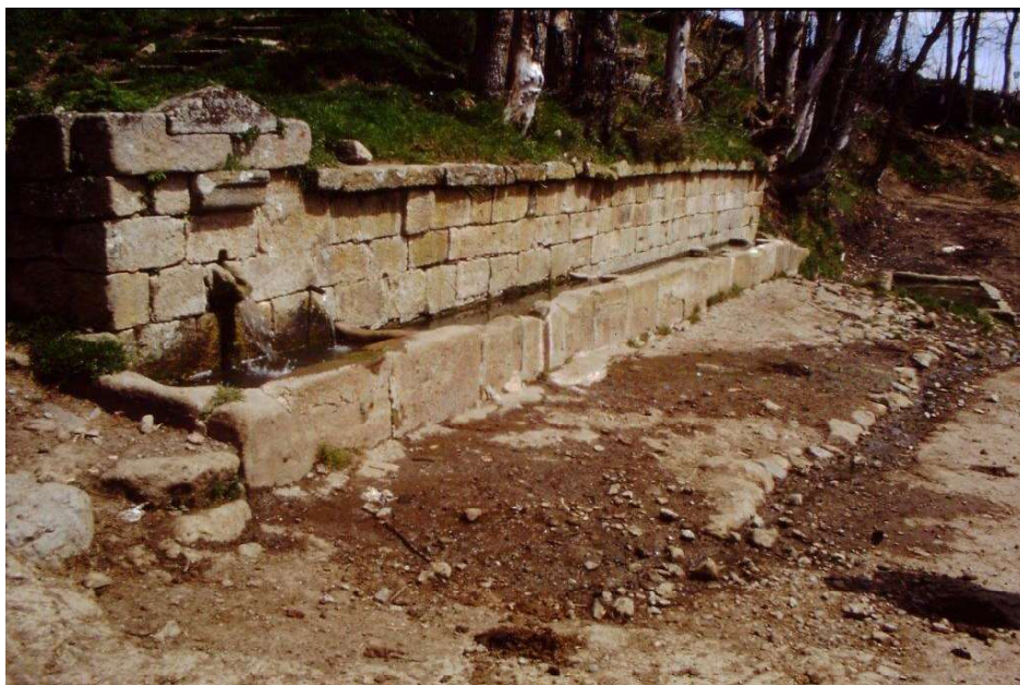
Foto 22 d: Aradillos en el conjunto de templo y fuente: La fuente destaca por las dimensiones y la regularidad de los sillares, más grandes los del pilón. Un resto de cornisa en el caño con remate de frontón.
