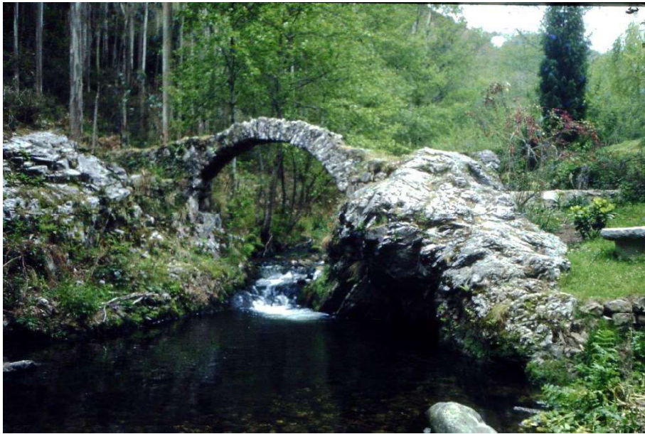
Foto 13: El puentecillo en Nueva, en el río Ereba, ornamental, lleva un antepecho defensivo por arriba. Y no descuidemos la conexión con inmediato molino.
