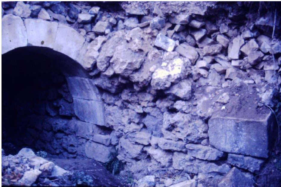
Foto 24: Puente . Puente en arroyo de Aradillos, tan regular en los arcos como irregular en la bóveda, también admirable por ese concepto.
