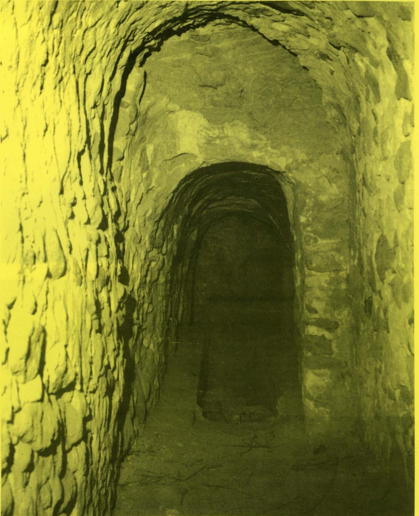
Foto 2.—Arranque de la galería de drenaje del qanat 3 junto al pozo A-2.
