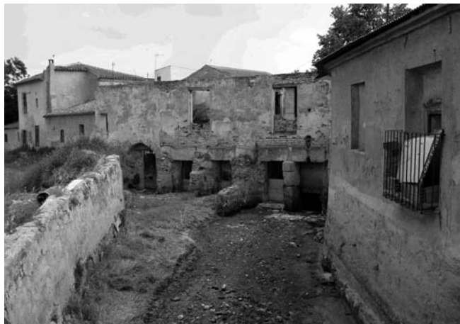
Demolición del molino de Oliver (S. XVIII) en 2008.
