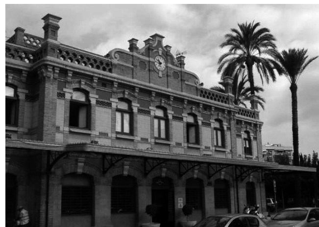
Estación de ferrocarril de Murcia-Zaraiche (1930) Fuente: Fotos del autor.
