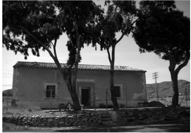
Casilla de peones camineros de la carretera de tercer orden de Cartagena a Mazarrón. Fuente: Fotos del autor.
