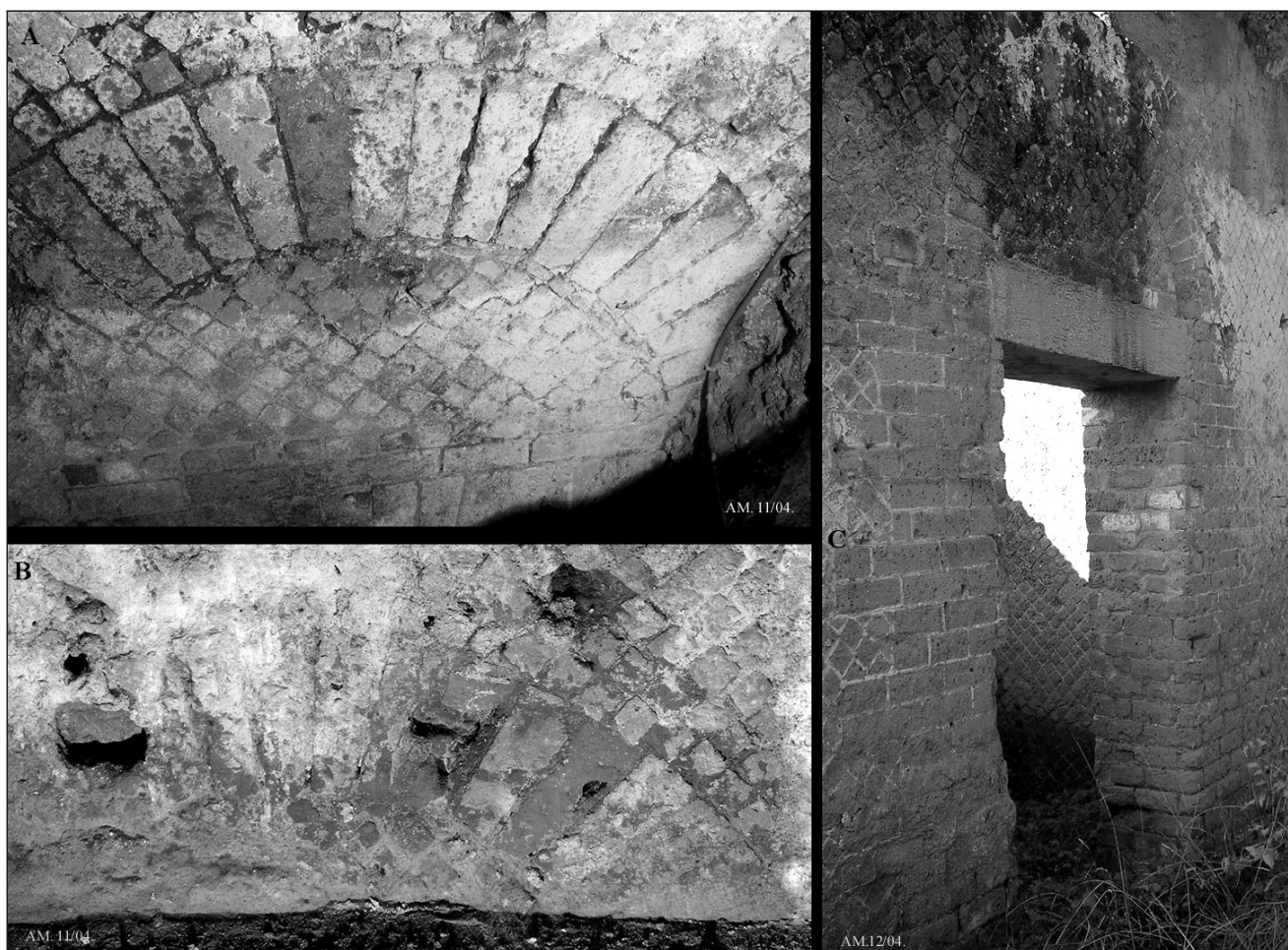
Lámina 5. Teatro de Pompeyo. A. Arco de descarga de vano radial. B. Arco de descarga de un vano del itinerario anular. C. Teatro de Otricoli. Vano interno.
