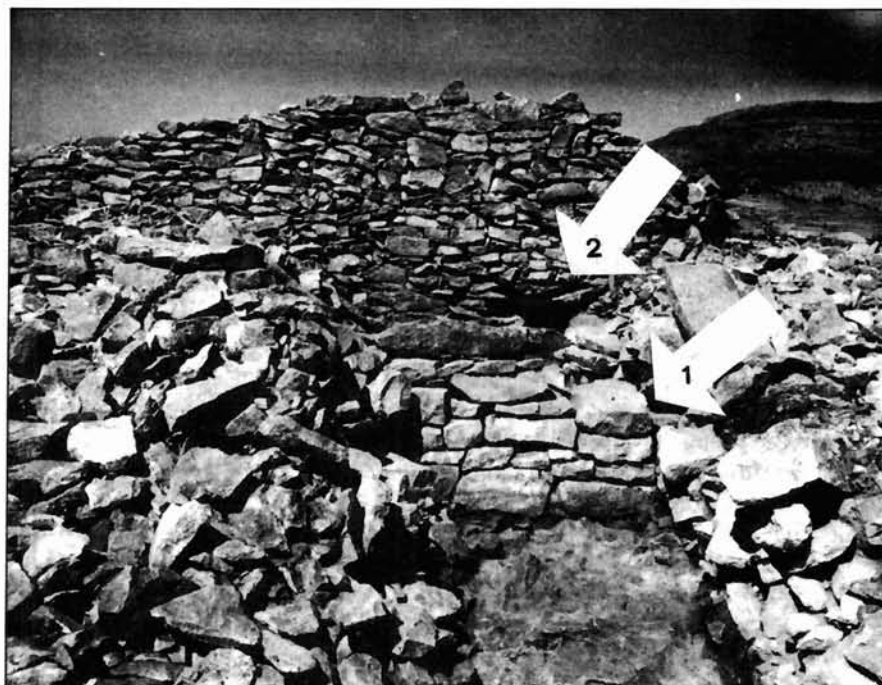
LÁMINA 1. El Castillico: la muralla, donde alcanza 4,5 m. de altura, desde el corte núm. 1, en el cual se aprecia el ángulo (flecha 1) de la torre cuadrangular, y la puerta que atravesaba la muralla (flecha 2) que había sido obturada por el relleno de la base de la torre cuando aquella fue añadida.
