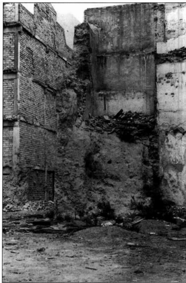
FIGURA 3. El mismo torreón de la figura anterior. Apréciase cómo la parte superior fue reaprovechada al construir el edificio moderno, instalándose varias dependencias en el interior de la estructura defensiva. La parte inferior, sin embargo, conserva el relleno original de tierra apisonada.
