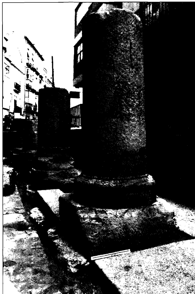
LÁMINA III. Columnata de la calle Morería Baja.
