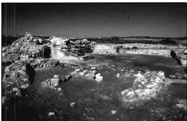
Lámina 11. Vista posterior de la exedra. A la derecha, restos del pavimento del pasillo de servicio que rodeaba la misma. En segundo término, escaleras de acceso a las estancias calefactadas y la gran sala del frigidarium .
