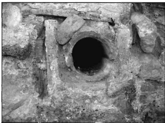
Lámina 8. Detalle del orificio de desagüe para abastecimiento de la piscina del frigidarium .
