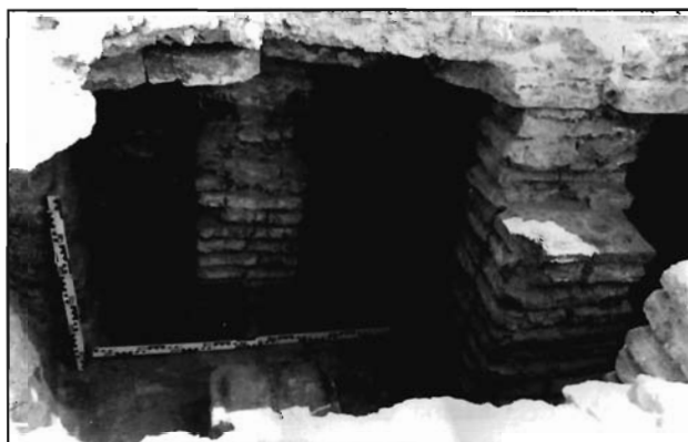
Lámina 20. Detalle del sistema de suspensura documentado bajo el pavimento del alveus del caldarium : dos columnillas centrales integradas por parejas de ladrillos rectangulares y columnillas de un solo ladrillo adosadas a los muros perimetrales. Entre todas soportan una plataforma de 6 ladrillos bipedales sobre la que se dispone el pavimento de mortero hidráulico.
